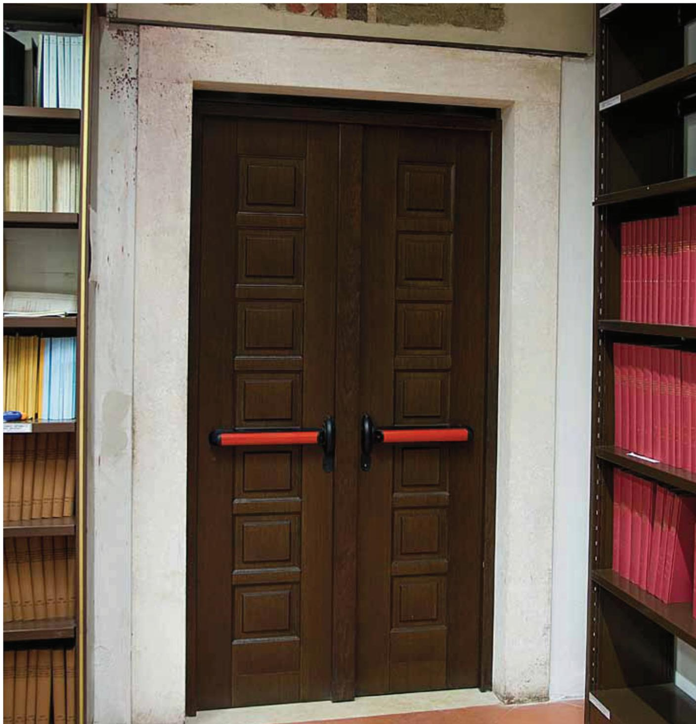
Le porte **Scudo** sono porte tagliafuoco a base metallica, con specifica certificazione ed omologa che impiega in modo ottimale i pregi di due diversi materiali: l'acciaio e il legno. Quest'ultimi non sono un semplice rivestimento, sono una combinazione che sfrutta la sicurezza e l'inalterabilità dimensionale delle chiusure metalliche arricchendole nelle parti esposte (anta e telaio) di ogni espressione consentita dal legno.
