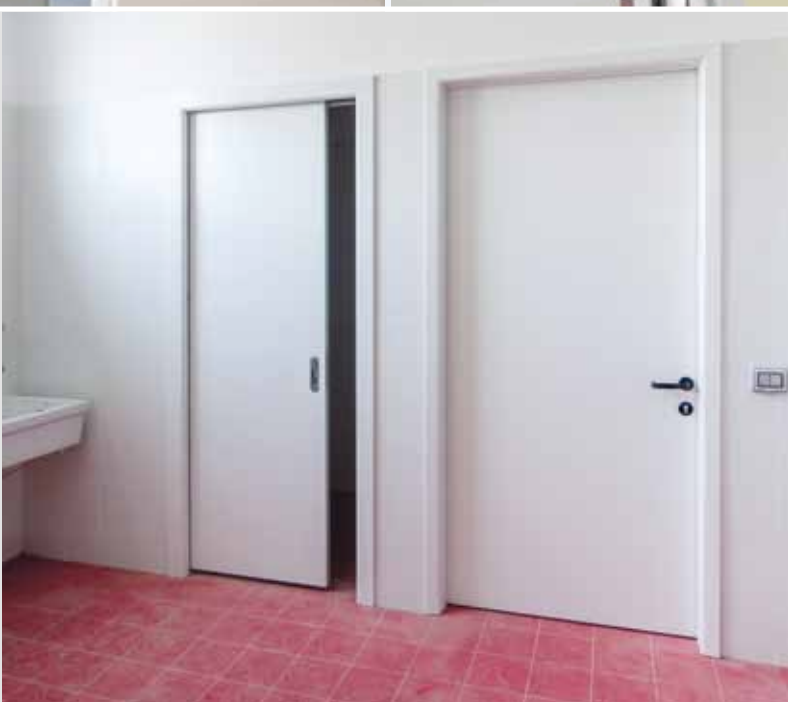
Sezioni apertura scorrevole interno muro.
